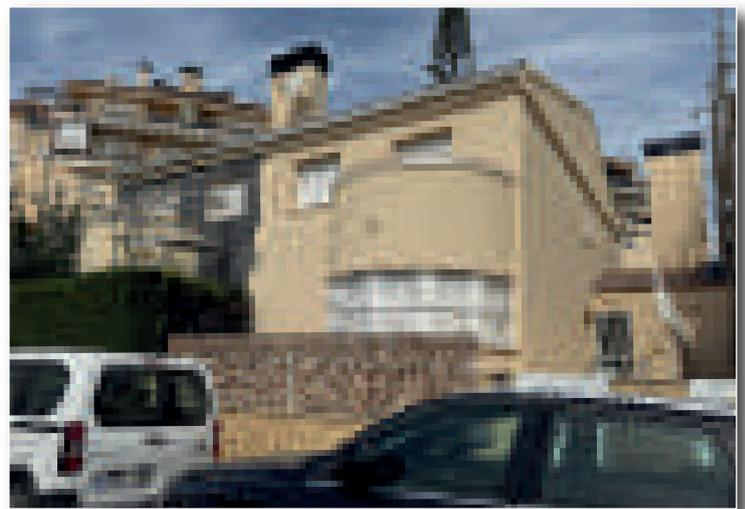
*Como se observa en la parte superior derecha de la fachada de uno de los pareados ya terminados, se han aumentado las rejillas de ventilación para generar ventilación natural cruzada en la cámara bajo la cubierta.*
