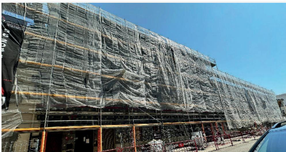
Además de la instalación de SATE y de subsanar las múltiples patologías que presentan las fachadas y el cerramiento por la parte interior (humedades, mohos, etc.), las obras abarcan la rehabilitación de las estructuras dañadas (fisuras en viguetas o filtraciones), renovación de las bajantes, la eliminación del fibrocemento de tejados, y la instalación de sistemas de energía aerotérmica que mejoran hasta un 45% el consumo.
