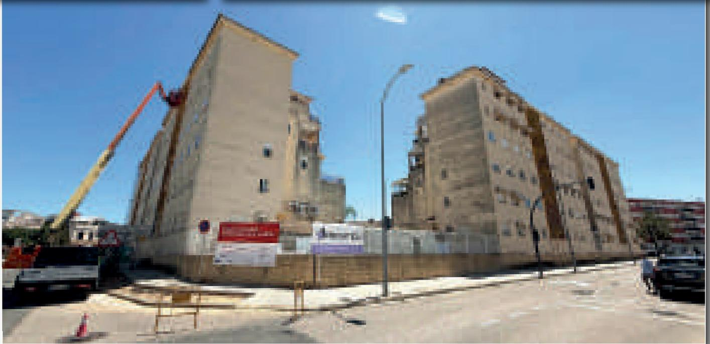
las viviendas no presentan problemas estructurales graves, sin embargo las fachadas, incluyendo las de los patios interiores, debido a la existencia de un mortero monocapa, un recubrimiento muy susceptible al deterioro, cuyo uso se extendió aplicándose de forma indiscriminada a partir de los años 80 por toda nuestra geografía, presentaba fisuras, desconchados y una suciedad generalizada como se muestra en las imágenes superiores.
