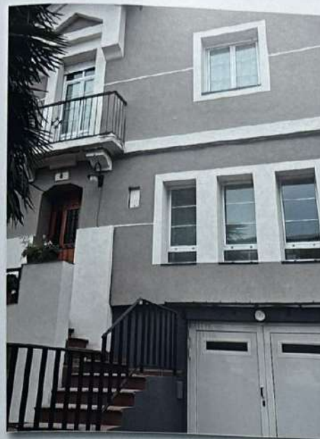
Obra realizada por La Casa del Sate de Asturias, con Sate suministrado por SATE Fachadas y Pinturas.
